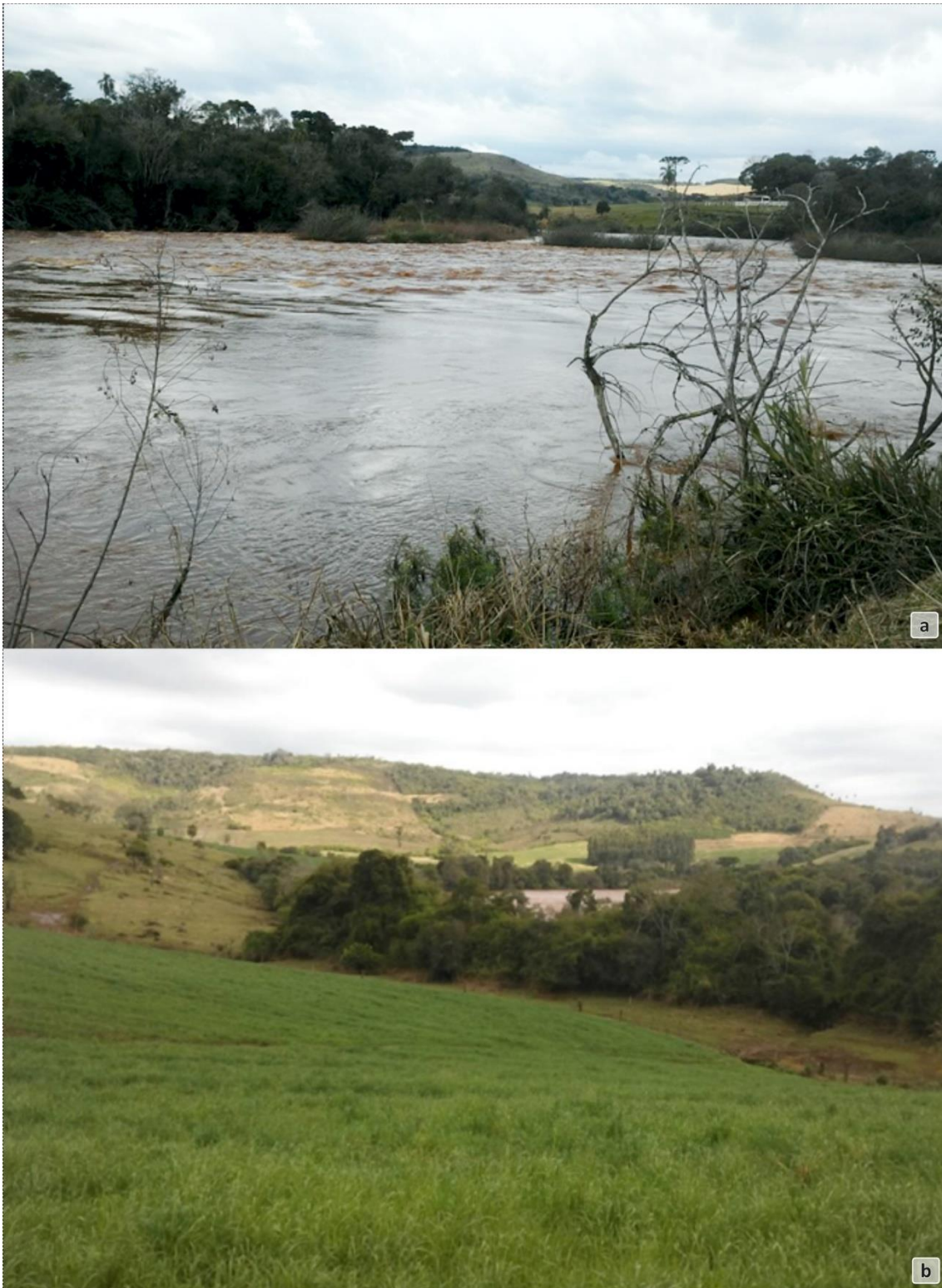
Figura 4 - Área do empreendimento. [a] Local da soleira de regularização. [b] Local da casa de força.
